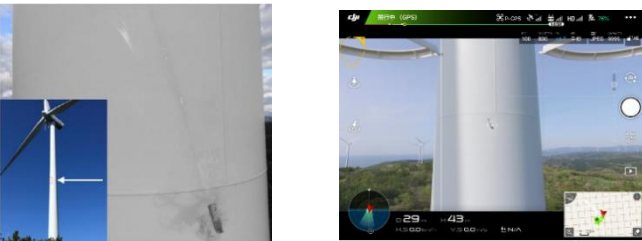
図-6 タワーのブレード打痕
