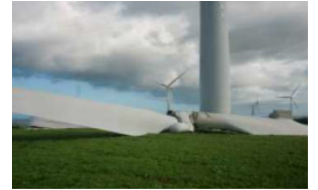
図-3 ロータハブ落下状況
