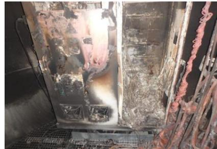
図1-4 制御盤焼損状況
