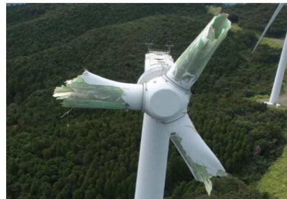
図1-4 10号機破損状況
