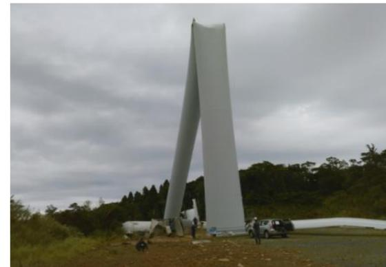
図1-3 8号機破損状況
