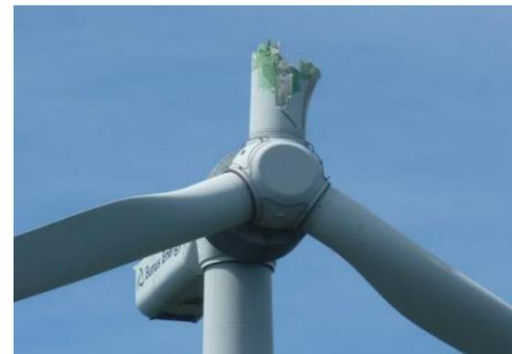
図1-5 13号機破損状況
